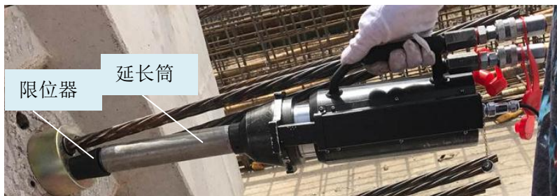
图 4.2 安装千斤顶示意图
